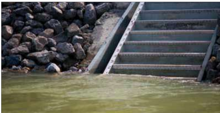
Pegellatte an einer Pegelmessstelle; beispielhafter Wasserstand am Pegel von 95 cm
