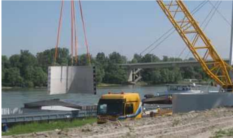
Umschlag von Betonsegmenten in Bad Deutsch-Altenburg
