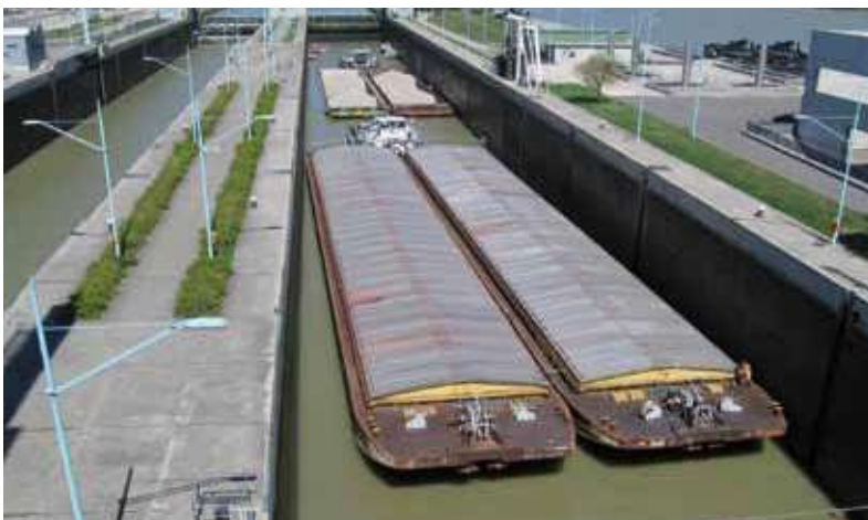
Schleusenanlage des Flusskraftwerks Wien-Freudenau (Strom-km 1.921,05)
